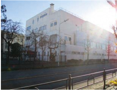
市内小学校の体育館
