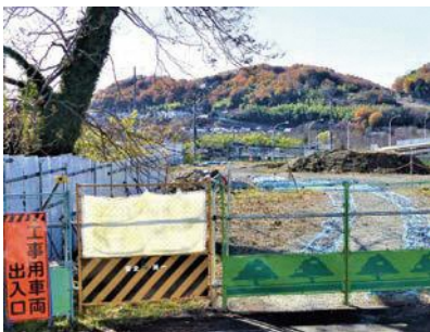
羽村大橋に接続させる道路予定地
