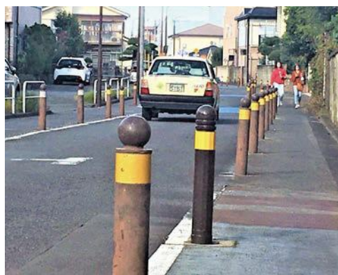
▲交通量抑制のため、車止めで道路を狭める第三工区
