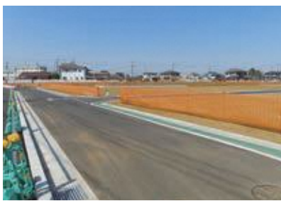
区画整理で造成工事完了間近の川崎4丁目エリア
