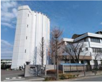
安全な水を供給する羽村市水道事務所
