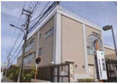
羽村堰近くにある東京都水道局羽村取水管理事務所
