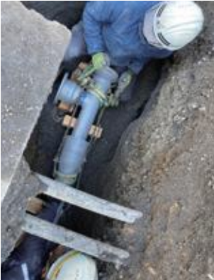
災害時の断水等の影響を最小限にするため、耐震管への管種替えをする様子
