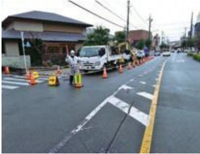
市内道路建設工事現場
