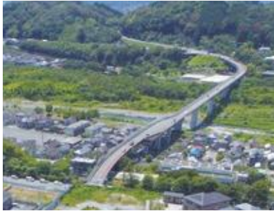
東京都が工事を行う羽村大橋
