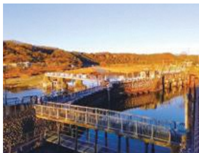
玉川上水の起点であり、土木学会選奨土木遺産に認定された羽村取水堰（投渡堰）周辺
