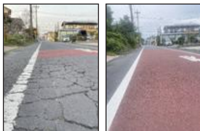
市道の改修前(左)と改修後(右)
