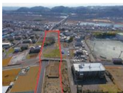
羽村大橋から新奥多摩街道までの用地空けが進む
