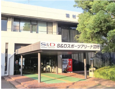
冷房設備設置と大規模改修を検討している羽村市スポーツセンター
