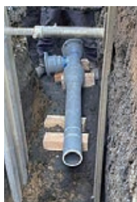
▲耐震管設置の様子
