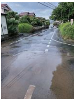
▲令和6年の漏水事故
