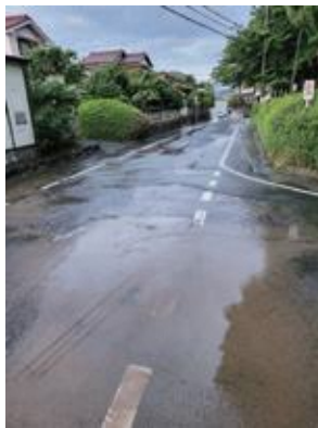
▲令和6年の漏水事故
