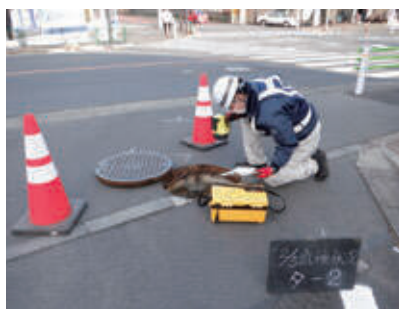
自主的に緊急安全点検を行った汚水管
