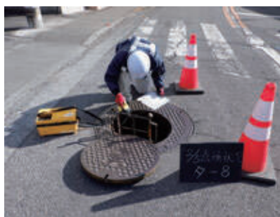
下水道管の目視点検の様子
