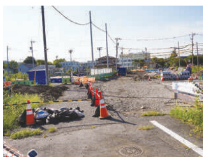
早期開通が望まれる都市計画道路3・4・12号線羽村大橋付近
