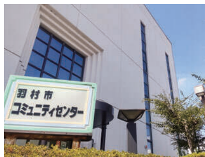
市内では公共施設の設備故障が相次いでいる
