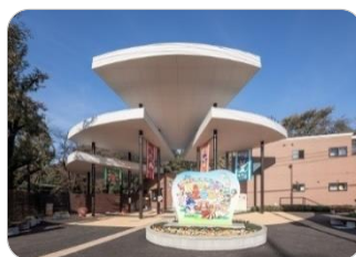
平成30年8月 エントランス・管理事務所改修 シンボル看板新設
