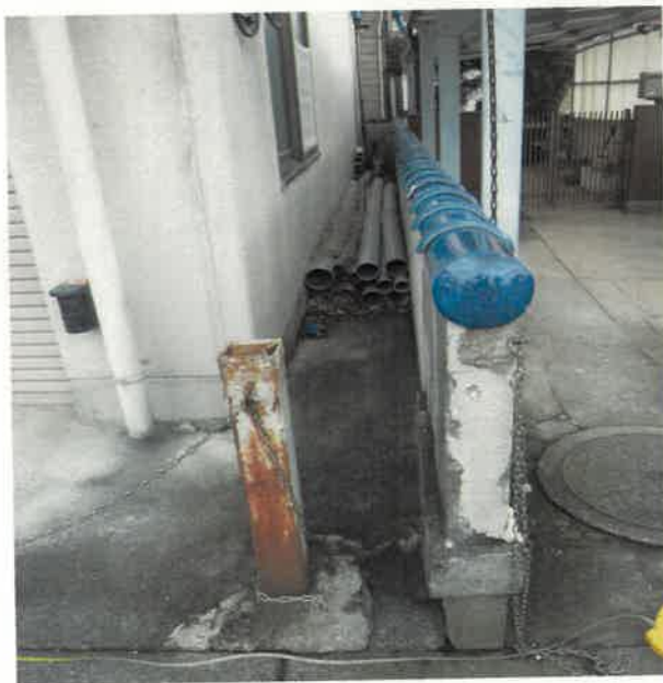
南東側 階段①
