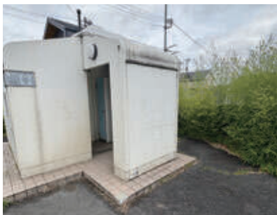
宮の下運動公園駐車場トイレ
