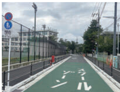
羽村東小学校横の整備された道路
