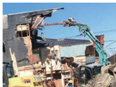
羽村駅西口地域の970棟を取り壊し移転させる区画整理
