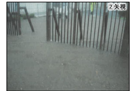
図 5-8 浸水状況(水道事務所北側)
